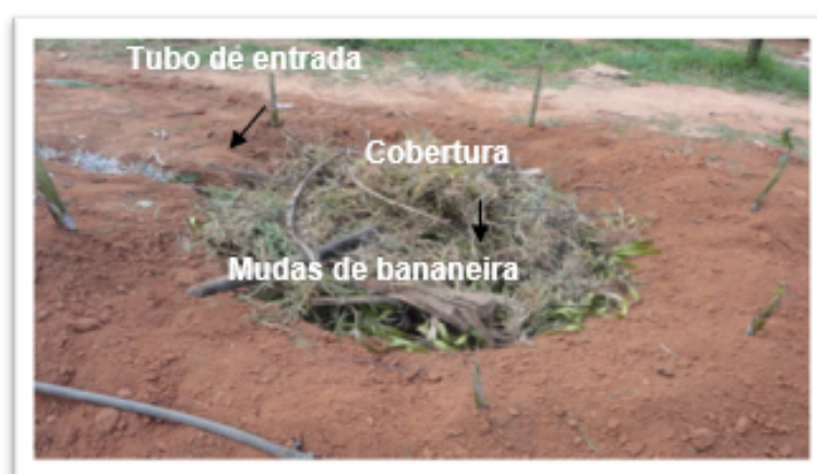
Figura 11 – Foto Ilustrativa – Construção do Círculo de Bananeiras
