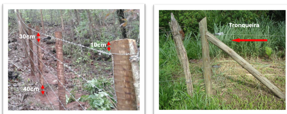
Figura 20 – Fotos Ilustrativas do modelo adotado para cercamento das nascentes Fonte: Localmaq (2017) - Município de Lassance, adaptado por SAMENCO (2020)
