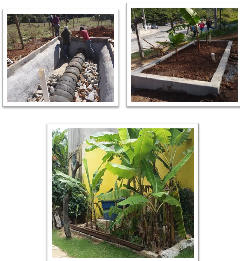
Figura 14 – Detalhe Construtivo – TEvap
