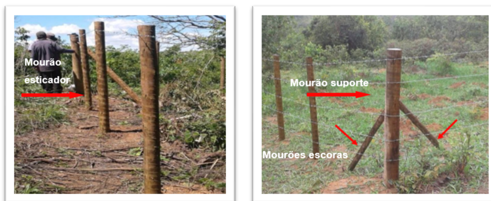
Figura 21 – Fotos Ilustrativas do modelo adotado para cercamento das nascentes Fonte: Localmaq (2017) - Município de Lassance, adaptado por SAMENCO (2019)
