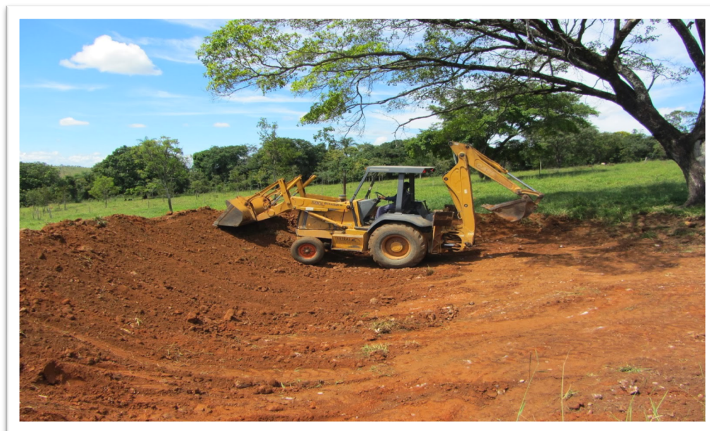
Figura 2 – Vista parcial da implantação de barraginha
