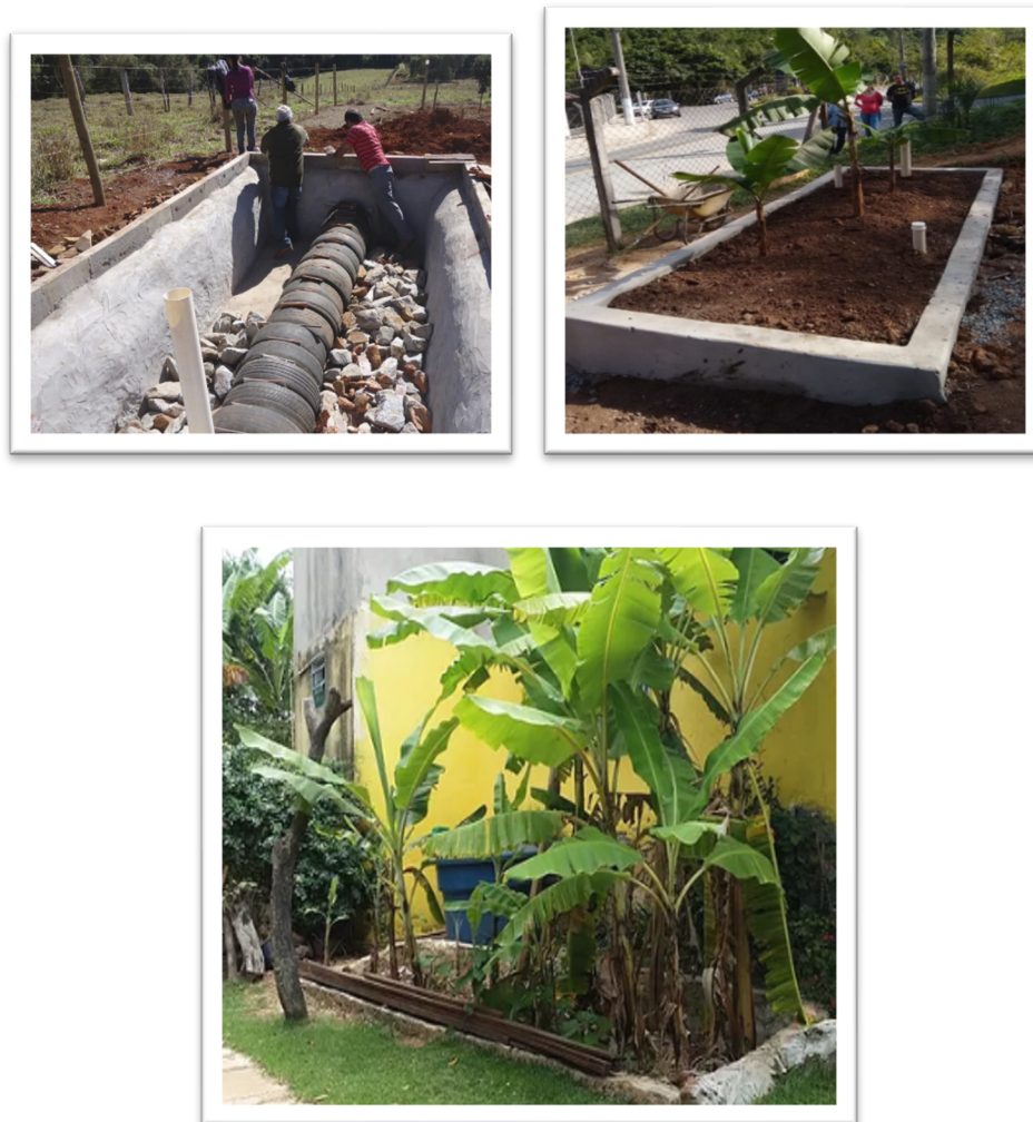
Figura 14 – Detalhe Construtivo – TEvap
