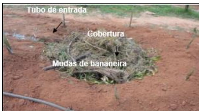
Figura 15 – Foto Ilustrativa – Construção do Círculo de Bananeiras
