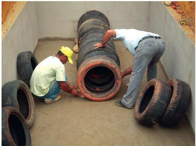
Figura 10 – Instalação da câmara receptora com pneus irreversíveis
