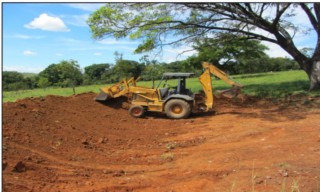
Figura 2 – Vista parcial da implantação de barraginha
