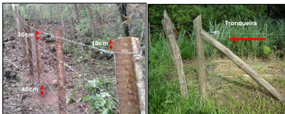
Figura 4 - Fotos Ilustrativas do modelo adotado para cercamento das nascentes
