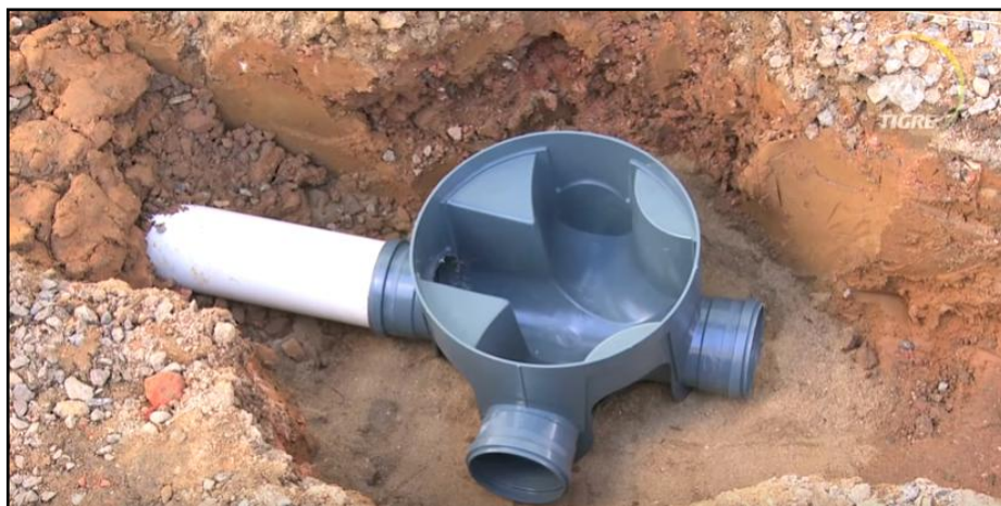
Figura 14 – Detalhe da instalação de uma Caixa de Passagem/ Inspeção propostas pela SAMENCO
