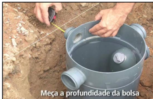
Figura 12 – Detalhe da instalação de uma Caixa de Gordura
