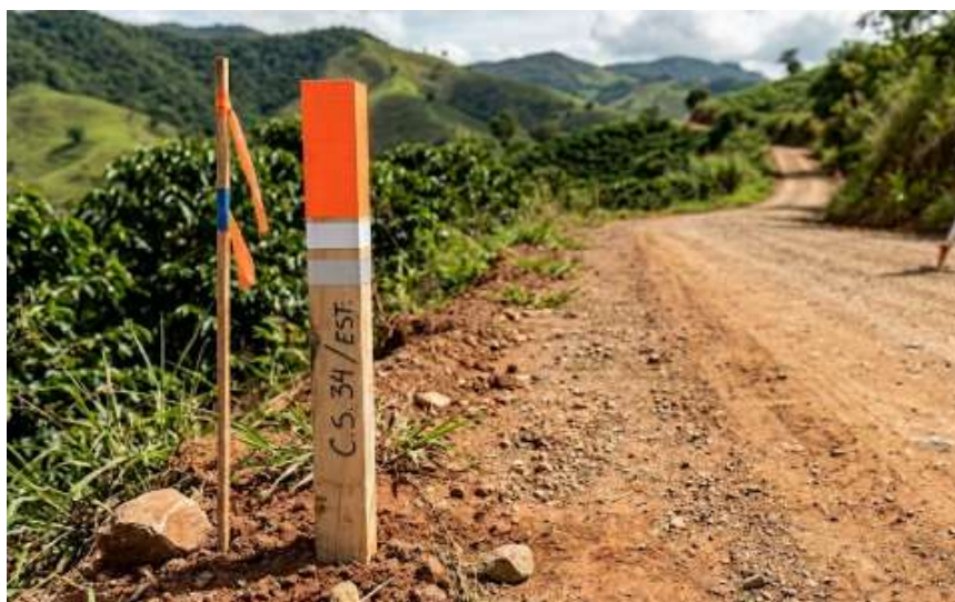
Figura 8 – Exemplo de locação dos piquetes
