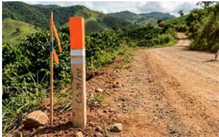
Figura 8 – Exemplo de locação dos piquetes
