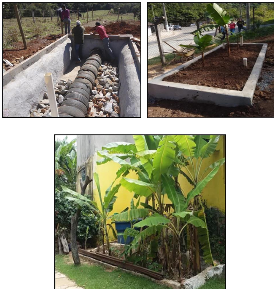
Figura 11 – Detalhe Construtivo – TEvap
