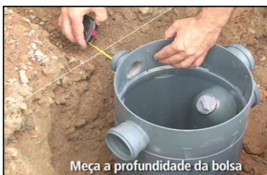
Figura 12 – Detalhe da instalação de uma Caixa de Gordura
