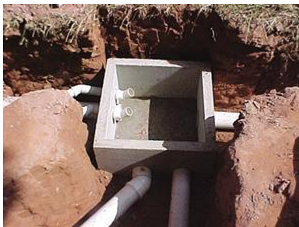
Figura 15 – Detalhe da instalação de uma Caixa de Passagem/ Inspeção propostas pela AGEDOCE
