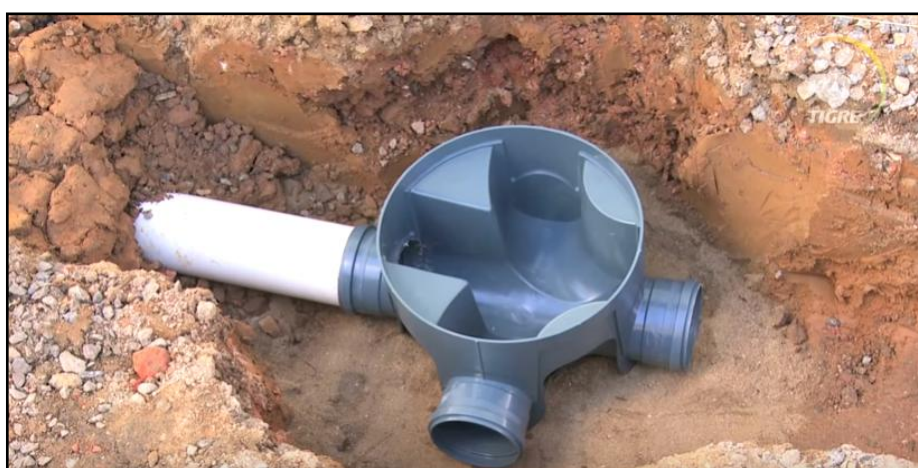
Figura 14 – Detalhe da instalação de uma Caixa de Passagem/ Inspeção propostas pela SAMENCO
