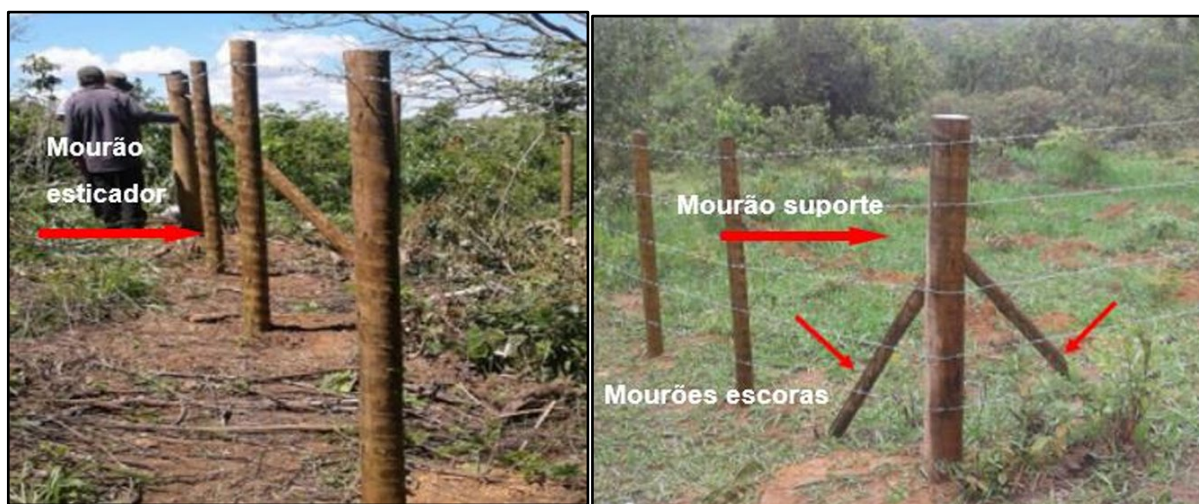
Figura 2 – Fotos Ilustrativas do modelo adotado para cercamento das nascentes
