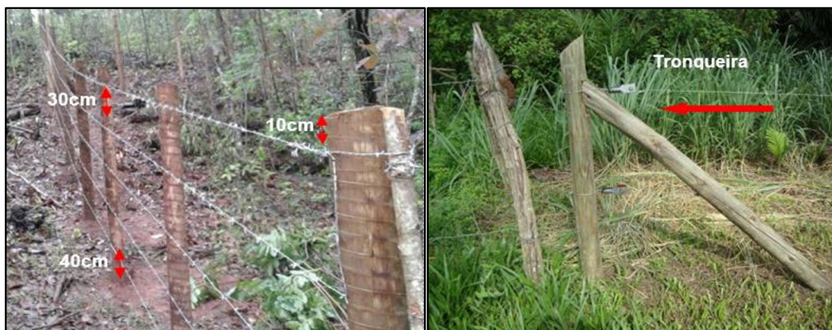
Figura 1 – Fotos Ilustrativas do modelo adotado para cercamento das nascentes
